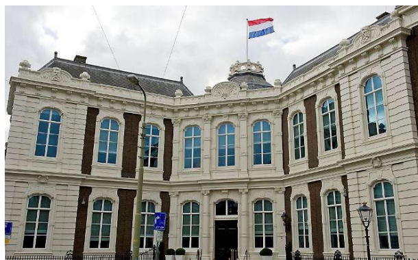
Gebouw van de Raad van State in Den Haag
